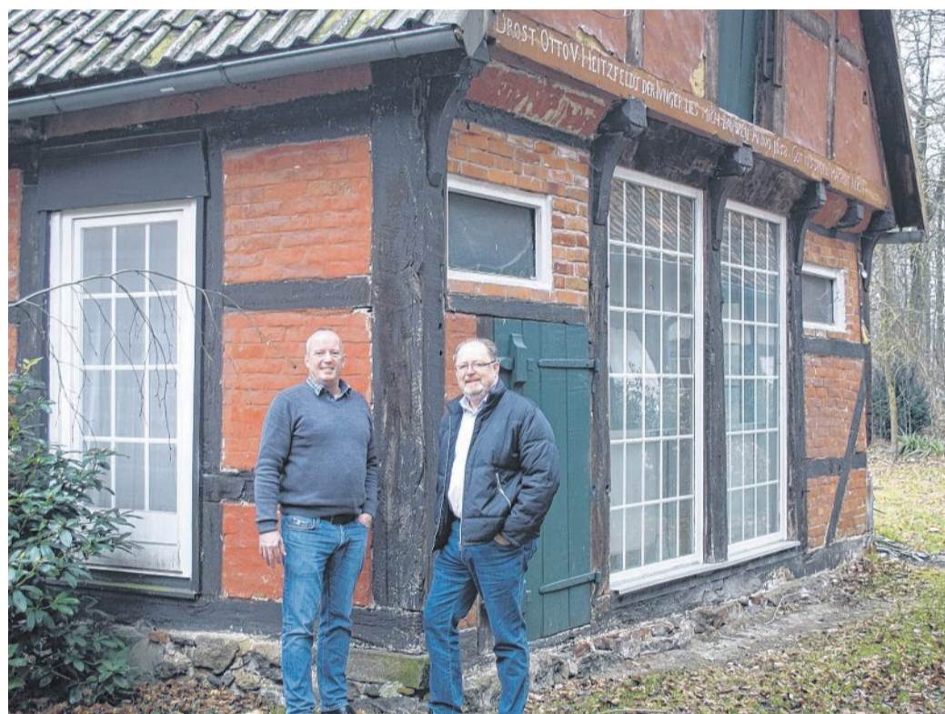
Dieses vor kurzem noch bewohnte Gebäude soll als Therapiehaus Mitte des Jahres umgebaut werden. Bernhard Schubert (links) und Wolfgang Witt freuen sich auf die Umbauten.
